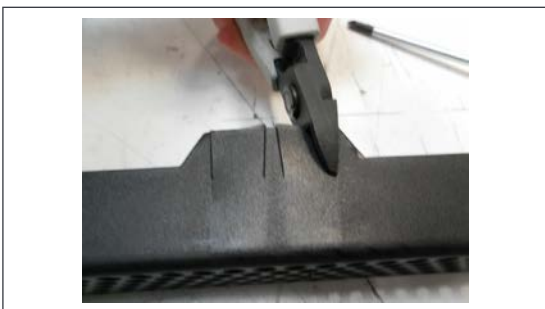
Faites des entailles pour le passage de câbles
